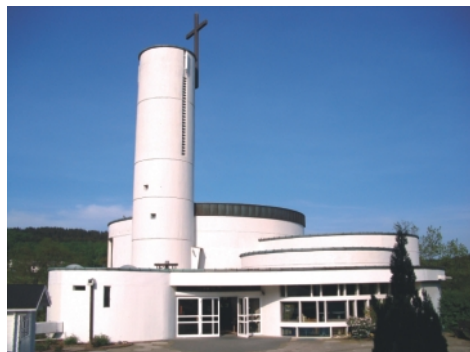
Auferstehungskirche Trupbach Am Wurmberg 5, 57072 Siegen-Trupbach
