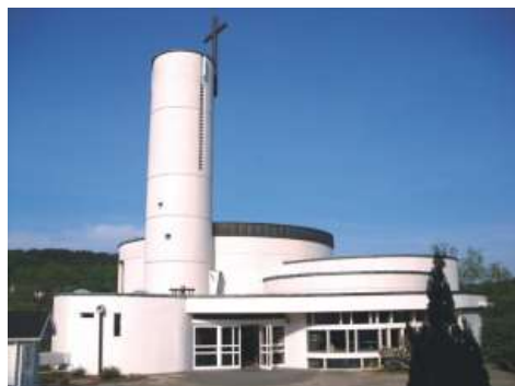
Auferstehungskirche Trupbach Am Wurmberg 5, 57072 Siegen-Trupbach
