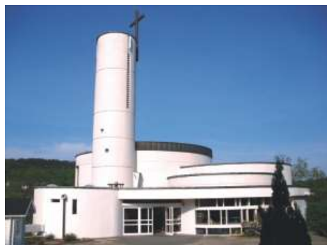
Auferstehungskirche Trupbach Am Wurmberg 5, 57072 Siegen-Trupbach
